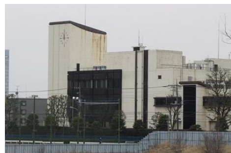
等々力水処理センター
